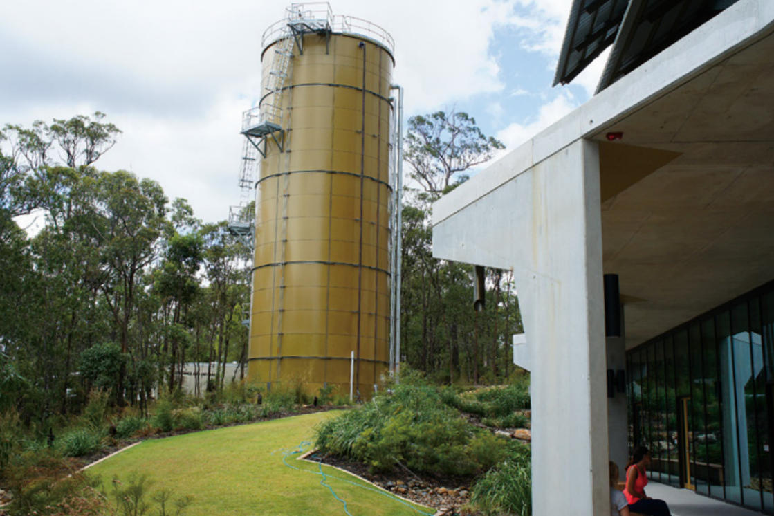
屋根には330キロワットの太陽光パネル。ビルの脇には冷房用の冷却水を貯めるタンクが立つ。
